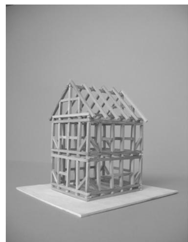
Einige Teile des Fachwerkhäuses, die bisher nicht durch eine Bezeichnung identifiziert worden sind und die im Modell besser zu erkennen sind als in der Zeichnung, sollten durch die entsprechenden Begriffe "Firstpfette", "Deckenbalken" und "Füllhölzer" ergänzt werden.
