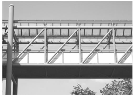
Fachwerkbalkenbrücke zur Verbindung zweier Gebäudeteile in Kassel (AVZ)
