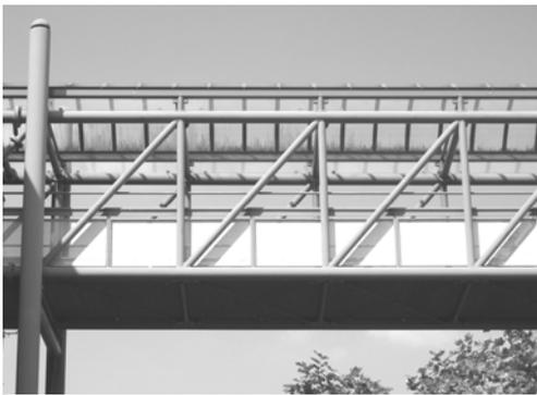
Fachwerkbalkenbrücke zur Verbindung zweier Gebäudeteile in Kassel (AVZ)
