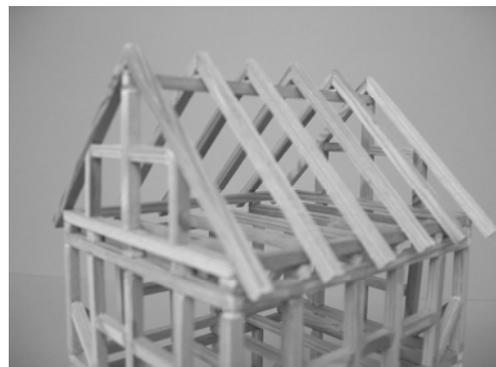
Im Modell kann darauf geachtet werden, dass die Streben immer paarweise angeordnet werden. Neben dem ästhetischen hat das auch einen statischen Hintergrund: Es können Kräfte aus beiden Richtungen aufgenommen werden. Die Hölzer werden auf Stoß bzw. auf Gehrung verbunden und geklebt, da die Ausführung der im
