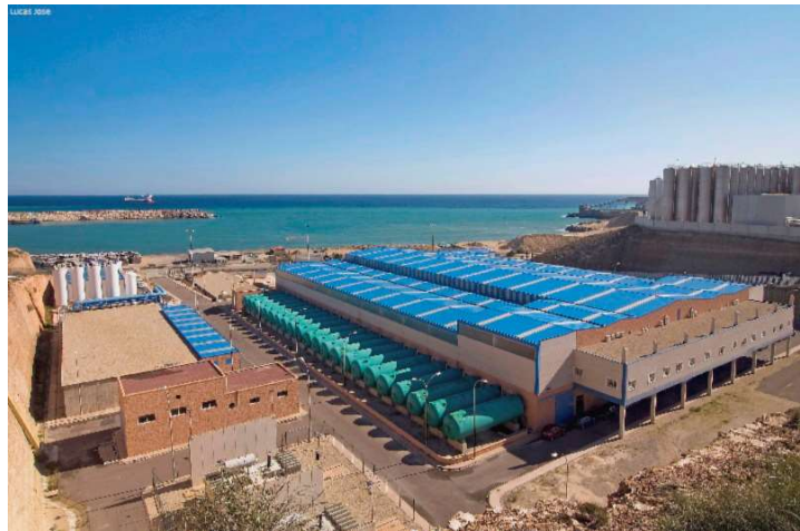
Wasserentsalzungsanlage zur Trinkwassergewinnung in Andalusien
