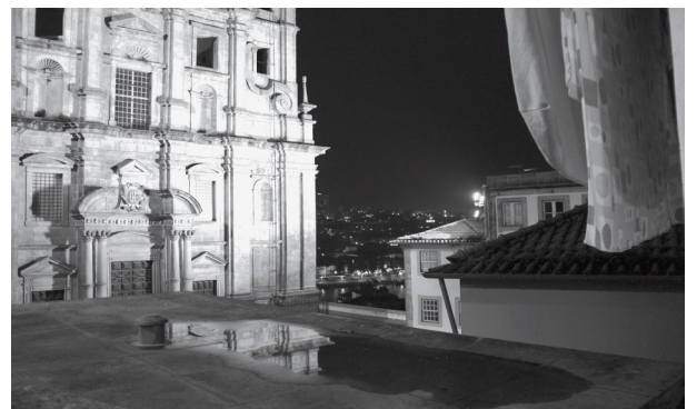
3 Die Nachtaufnahme mit der angestrahlten Kirchenfassade zeigt im Vordergrund eine interessante Spiegelung in der Pfütze.
