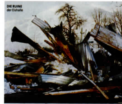
Zerstörte Eissporthalle – Bad Reichenhall – Pressefoto – 2.2.2006
